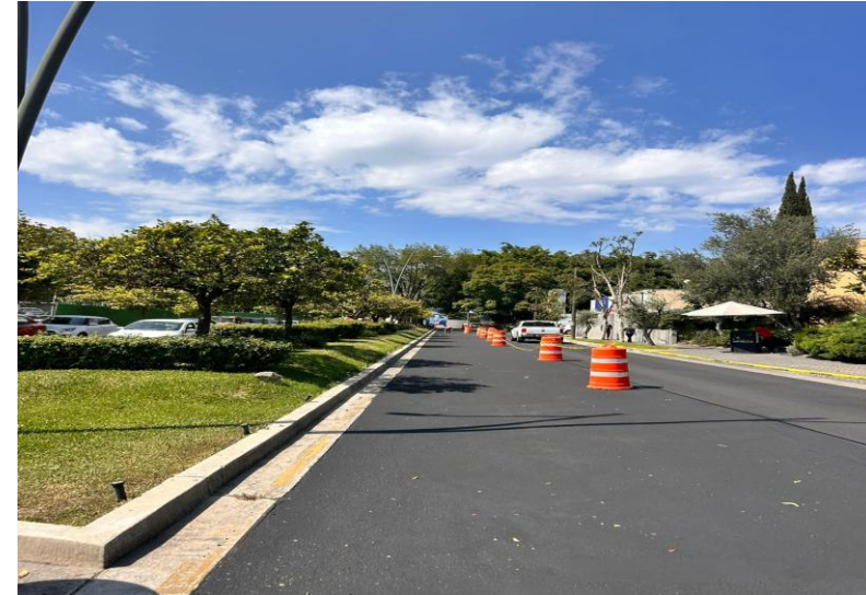
TRABAJOS DE REHABILITACION CARPETA ASFALTICA 1,471 M2 DIAG. GOLFO DE CORTES ENTRE CALLE HUICHOLAS Y AV. AZTECAS
