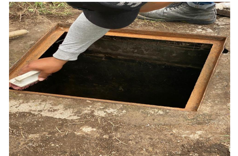
TRABAJOS DE DESAZOLVE POZOS DE ABSORCION PARQUE LINEAL AV. MANUEL ACUÑA Y GLORIETA MONRAZ
