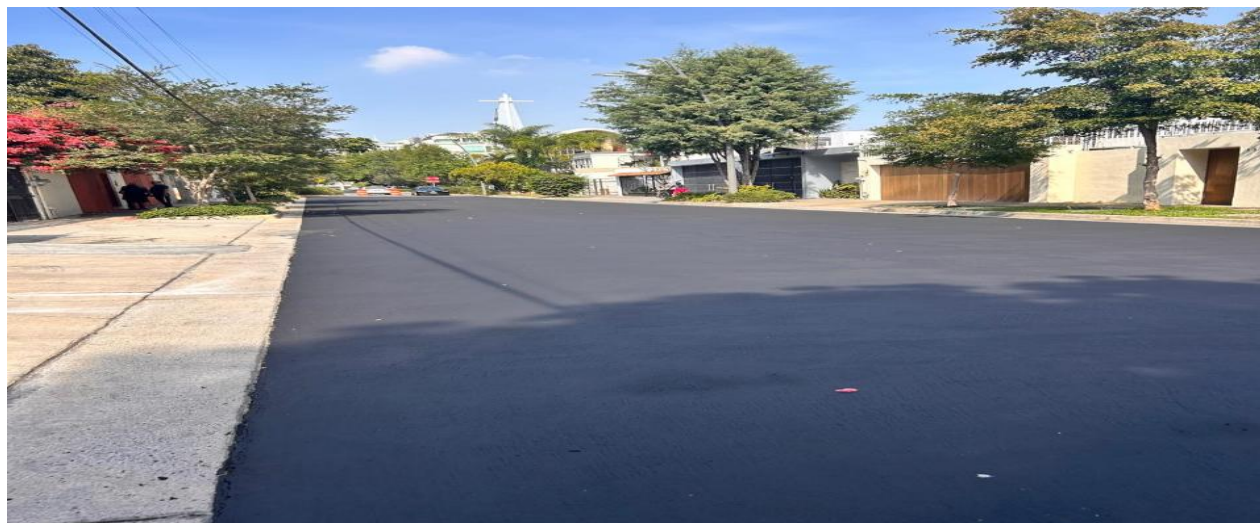
TRABAJOS DE REHABILITACION 759 M2 CARPETA ASFALTICA CALLE TARAHUMARAS ENTRE AV. MAYAS Y AV. TOLTECAS
