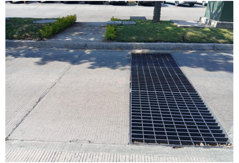
TRABAJOS DE DESAZOLVE POZOS DE ABSORCION DIAG. GOLFO DE CORTES Y REGISTROS NUEVOS PARA CAPTACION DE AGUA PLUVIAL.
