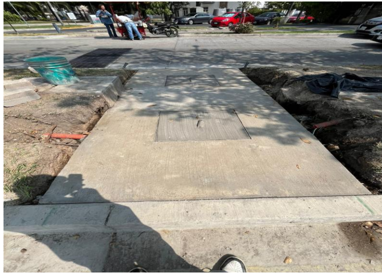
TRABAJOS DE DESAZOLVE POZOS DE ABSORCION DIAG. GOLFO DE CORTES Y REGISTROS NUEVOS PARA CAPTACION DE AGUA PLUVIAL.
